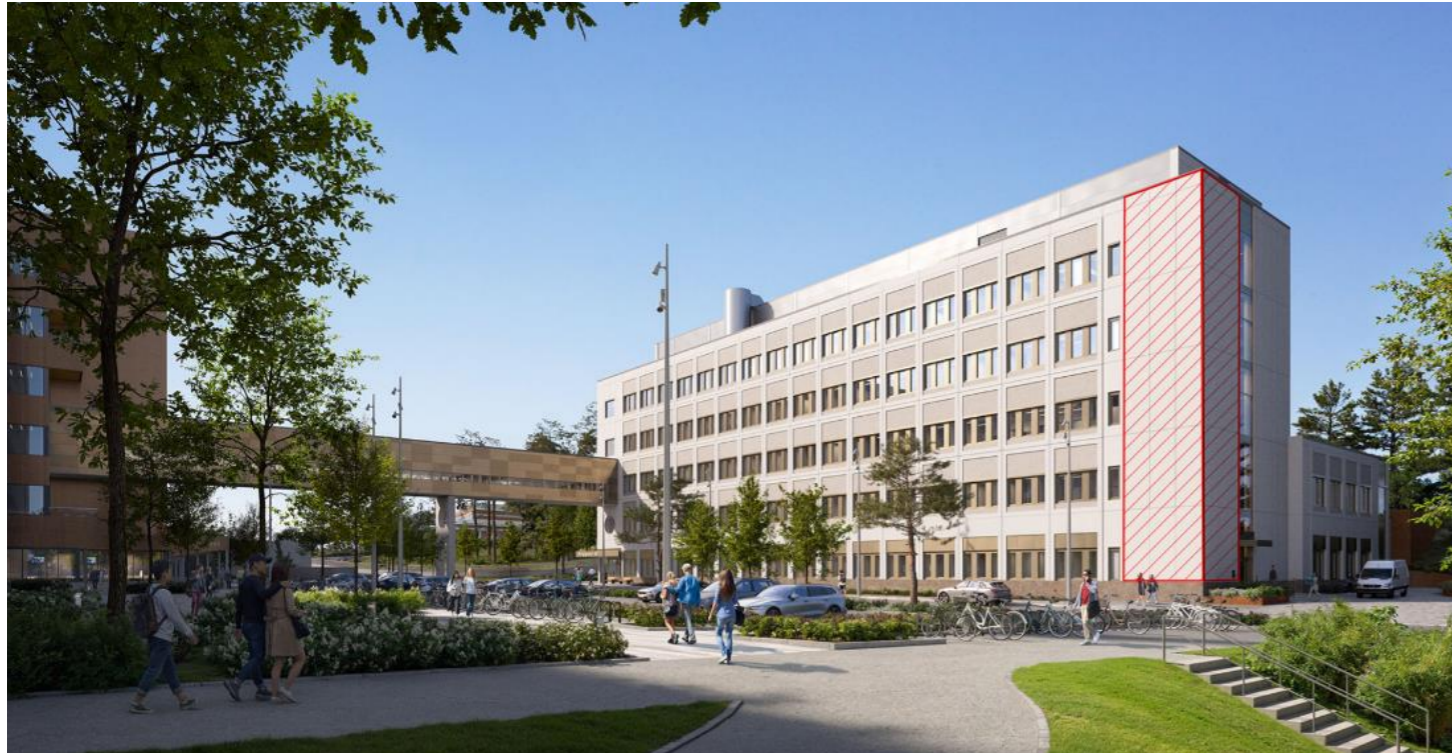
Exempel på plats för konst (rödmarkerad yta): hörnet av byggnad 95, sydvästra fasaden
