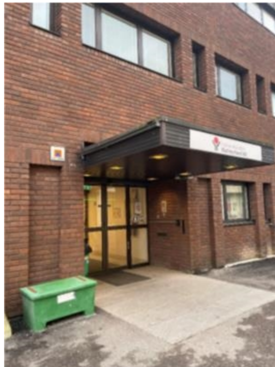
Befintlig entré mot Oxbackstorget. Nischerna i tegel (tidigare igensatta fönster) vill vi gärna ska synas i vindfånget och vara belysta på ett spännande sätt
