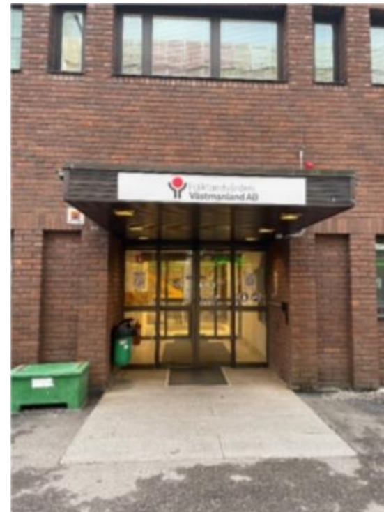
Befintlig entré mot Oxbackstorget är indragen och har ett skärmtak
